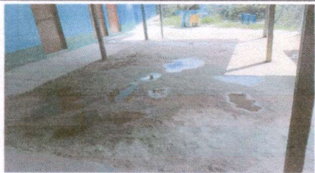
Foto 3: Reparacion plancha de concreto de patio.
