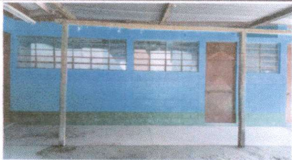
Foto 5: Fabricacion de e instalacion de balcon.
